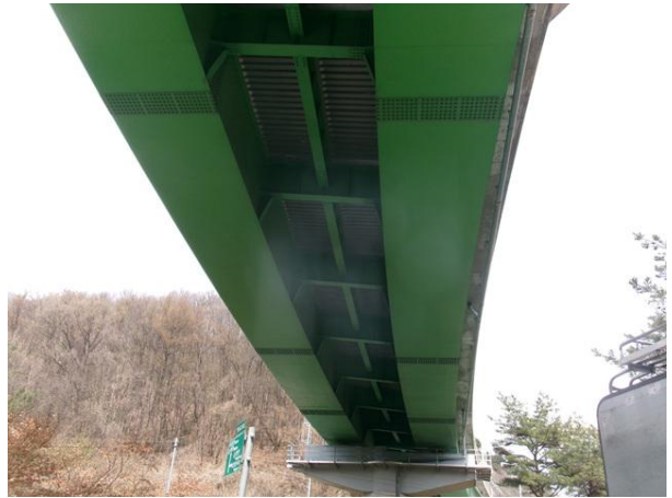
바닥판 하면 및 거더 전경
